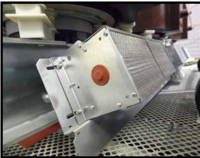
Электронное устройство контроля температуры в стандартной комплектации - реле DIEL MT200 lite, оно также может быть использовано для подачи сигнала на включение\отключения вентиляторов. Также трансформаторы можно снабдить вентиляторами уже после установки на место эксплуатации.
